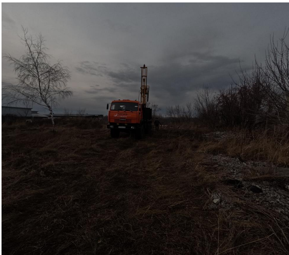
Рисунок Т.1 – Буровые работы (Скважина 1)
