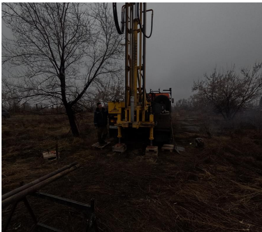
Рисунок Т.1 – Буровые работы (Скважина 4)
