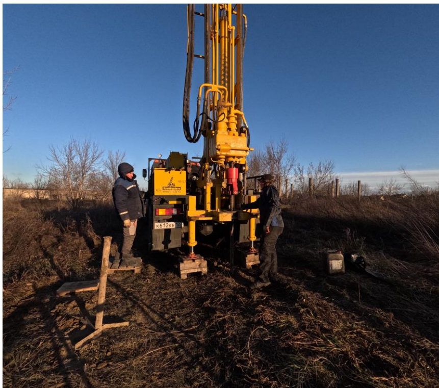
Рисунок Т.1 – Буровые работы (Скважина 6)
