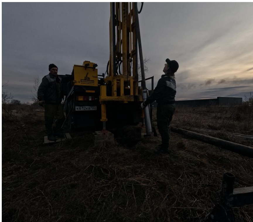
Рисунок Т.1 – Буровые работы (Скважина 3)
