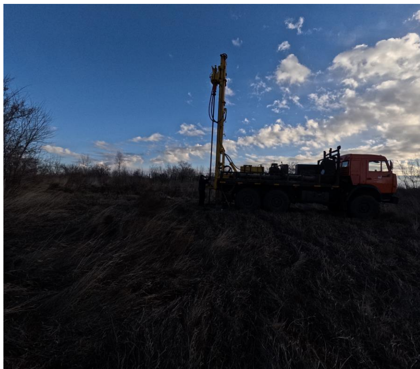
Рисунок Т.1 – Буровые работы (Скважина 5)
